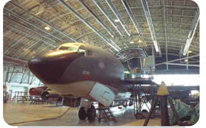
Uçak Hangarı Uygulaması: Seri Yakıclı Sistem - Genel Isıtma
